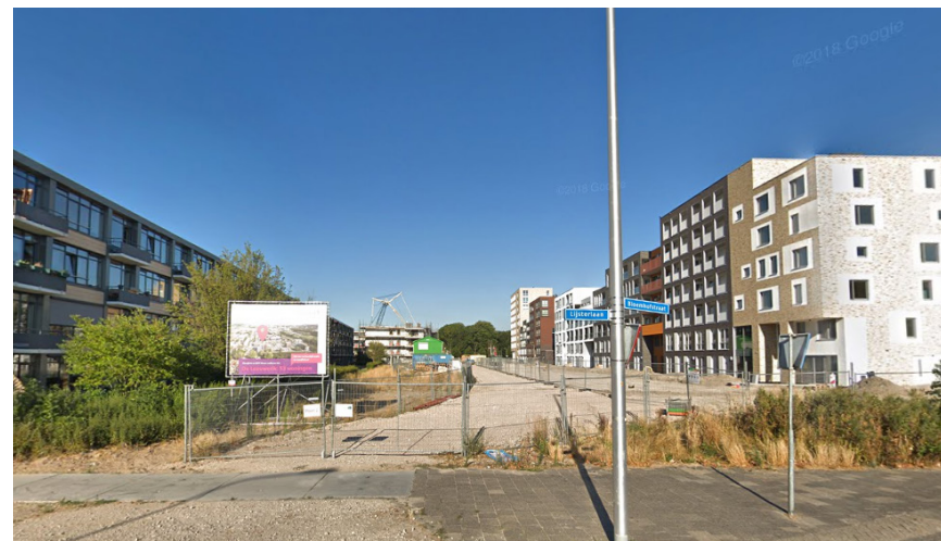
Afbeelding 2.9 Foto van de nieuwe bebouwing op de Thorbeckestraat
